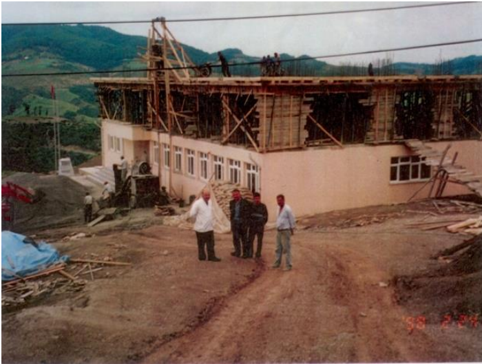
(Okulumuzun ikinci katının inşaatından bir görünüm.)
